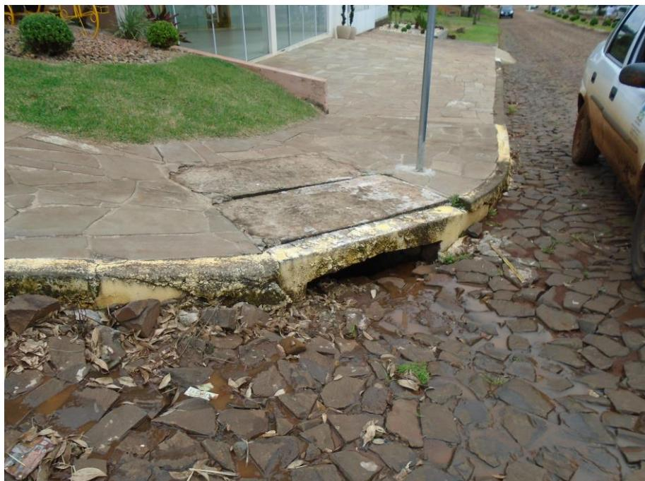
**Figura 44** – Drenagem pluvial existente no centro de Paulo Bento, em rua de calçamento
