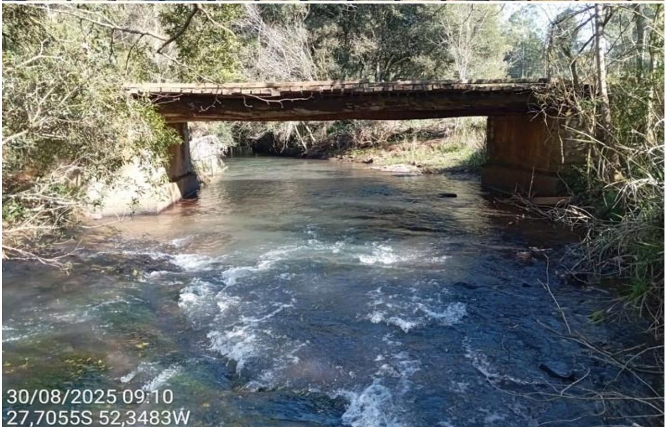
Figura 2- Registro Fotográfico de campo do Ponto 01 (Ponte 01) – evidenciando a seção transversal do rio e a ponte de madeira.
