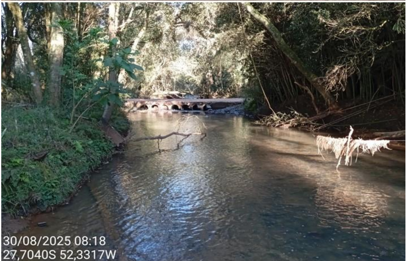
Figura 3- Registro Fotográfico de campo do Ponto 02 (Ponte 02) – evidenciando a secção transversal do rio e a passagem molhada em concreto.
